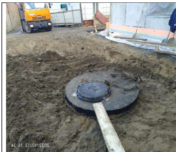
Капитальный ремонт водопроводного колодца между административными зданиями по ул. имени Ленина 40а и ул. имени Ленина 40а/1
