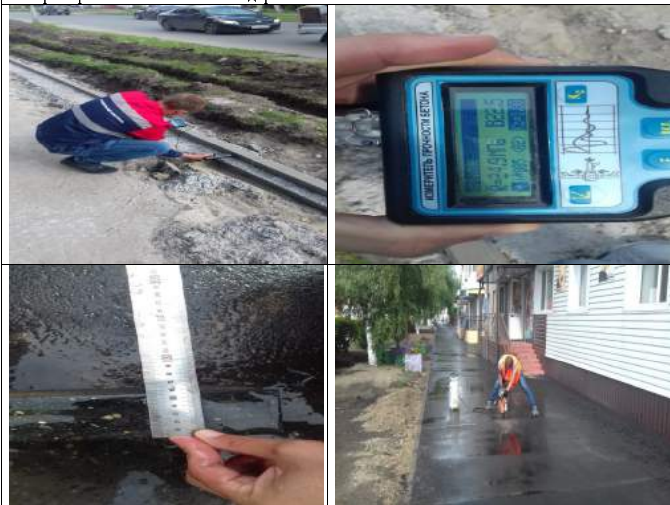
Контроль ремонта автомобильных дорог
