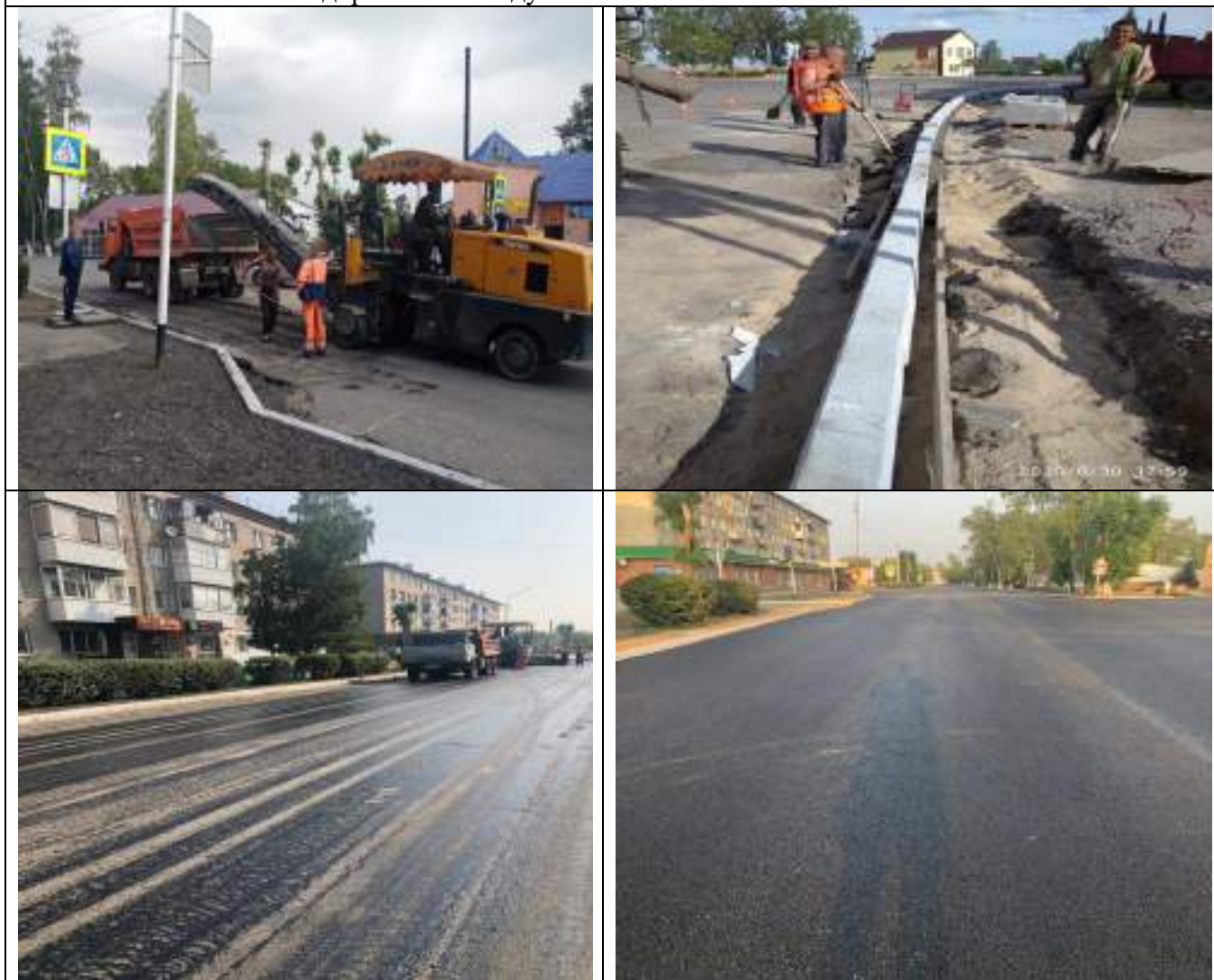
Ремонт автомобильных дорог в 2020 году
