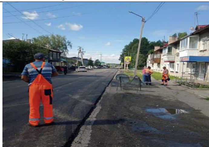
Фото ПОСЛЕ ремонта
